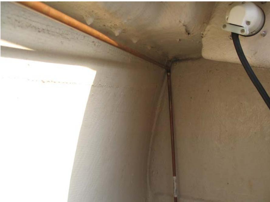
La conduite a été réalisée en tube de cuivre de diamètre extérieur 10 mm deux raccords ont été réalisés avec des coudes en cuivre à 90°. Ce sont les seules brasures qui ont été faites (vérifiées sous pression à l'eau savonneuse). Le tuyau souple (pour raccorder au réchaud d'un côté et le détendeur de l'autre) est monté sur le tube de 10 mm en forçant (utiliser de l'eau savonneuse pour aider) et assurer le montage bien sûr par des colliers spécial gaz.
